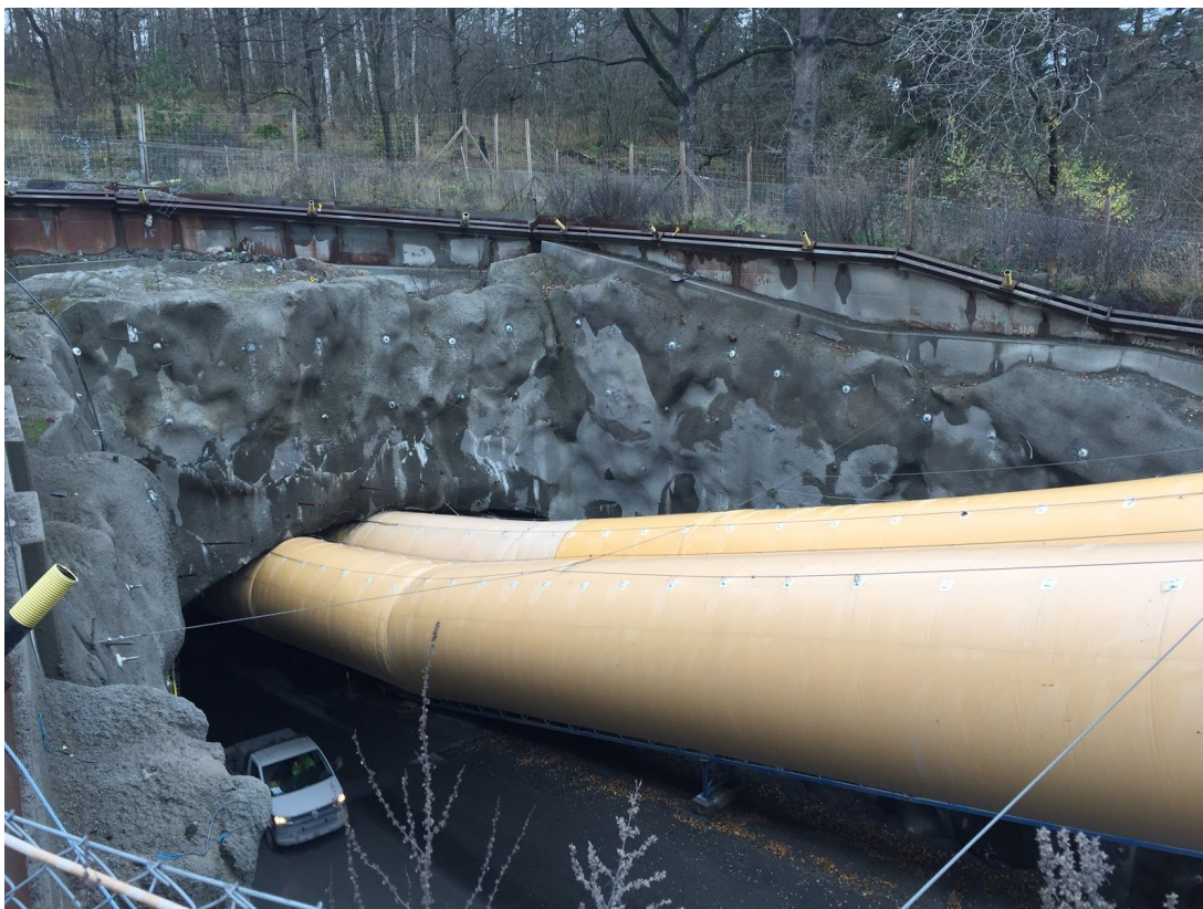
Bild 8: Arbetstunnelns mynning sett från öst (eget foto november 2019).
